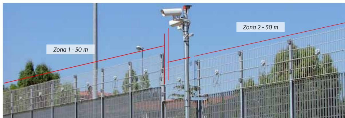
È quindi importante, in fase di progettazione, **suddividere il perimetro in modo che ogni linea-sensori protegga una sezione di recinzione con caratteristiche omogenee**: ciascuna linea di rivelazione si potrà così tarare sulle specifiche caratteristiche della struttura protetta.
